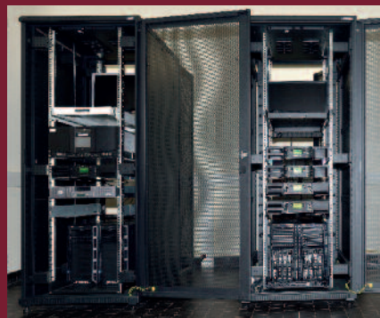
Plate-forme de migration sur bandes LTO au Centre national du microfilm et de la numérisation
