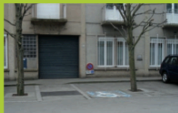
Une place de stationnement pour un véhicule qui n'offre pas la largeur nécessaire au déchargement sécurisé.
