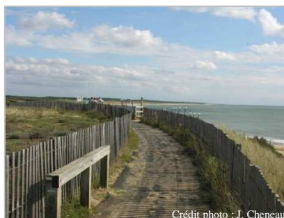
Pose d'écorce de bois et de ganivelles pour fixer la dune et canaliser le flux des randonneurs sur le sentier
