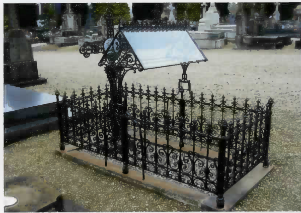
Montbray (Manche) : restauration d'une grille en fonte
