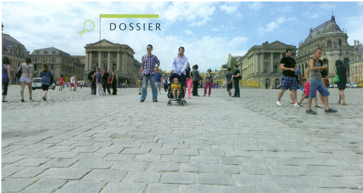
Entrée du château de Versailles : les pavés lisses ajoutent de la facilité de circulation, une sécurité accrue. Ils contribuent à une meilleure lisibilité du site, en plus de faciliter l'accès aux personnes handicapées. Pensés pour l'accessibilité, ces travaux participent à un accès facilité pour l'ensemble des usagers. Source : Actes du séminaire accessibilité du cadre bâti ancien protégé, ministère de la Culture et de la Communication, 2011.
